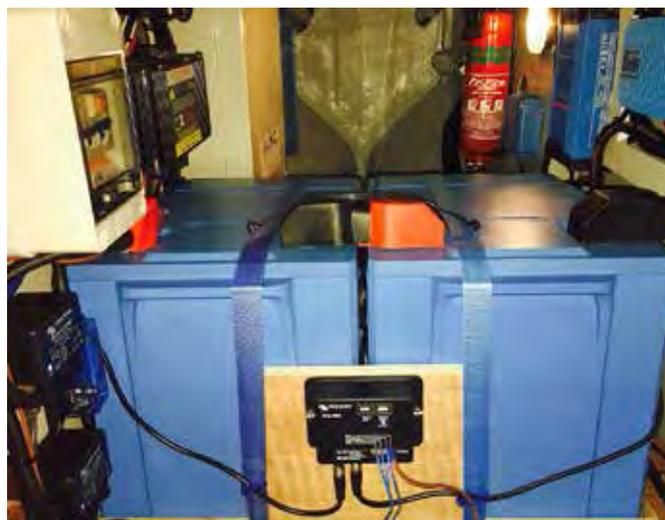
La imagen muestra 2 baterías de propulsión de 12,8V 200 Ah de fosfato de hierro y litio (LiFePO4 o LFP) con equilibrado de celdas y BMS (en el centro).
