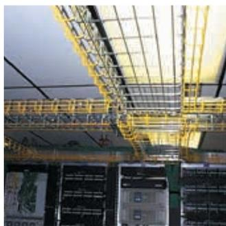
Rétix es la bandeja portacable tipo malla especialmente pensada para espacios reducidos y/o difíciles, por lo general asociados con instalaciones en armarios de comunicación. La bandeja permite construir con herramientas sencillas y en obra, las rutas del cable como curvas y cambios de dirección para acelerar el tiempo de instalación de manera rápida y segura.
